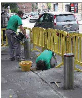
Lavori Porta Nuova
